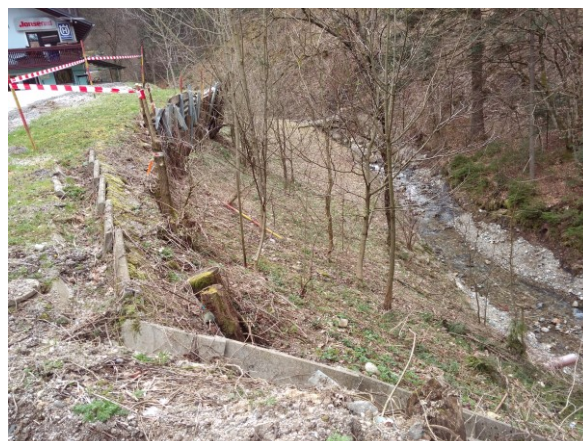
Slika 4: Obstojeca brežina na kateri se predvideva varovanje z duktilnimi piloti
