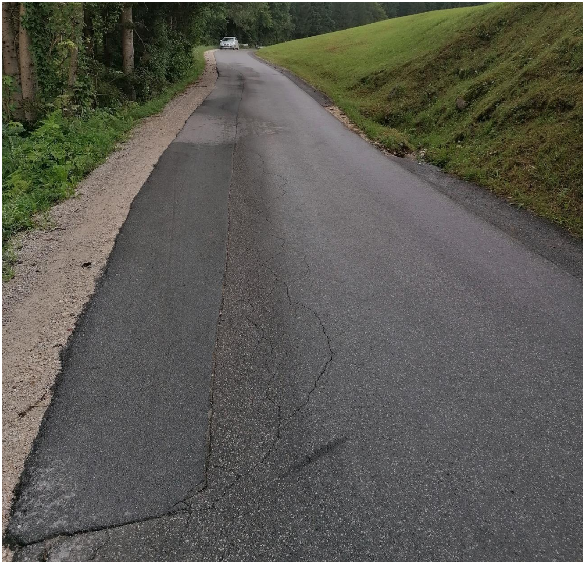
Slika 2: Poškodbe vozišča
