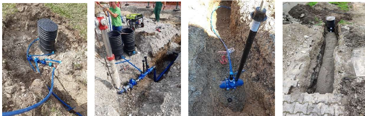
Slike: Primeri izdelave ali obnove vodovodnih priključkov s prestavitvijo vodomera v zunanji termo jašek
