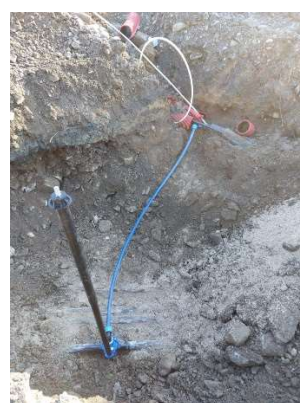
Slike: Obnova vodovoda in vodovodnih priključkov zaradi defektov – mizarstvo Tostovršnik loke in Lovski dom Ljubno
