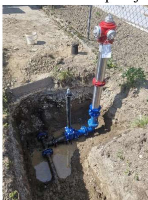
Slike: Obnova vodovoda in vodovodnih priključkov zaradi defektov – mizarstvo Tostovršnik loke in Lovski dom Ljubno
