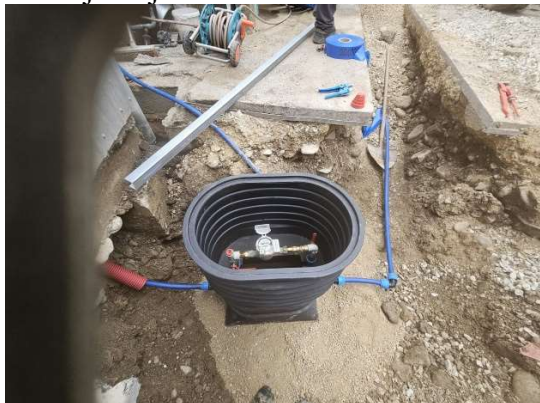
Slike: Obnova vodovoda in vodovodnih priključkov zaradi defektov – mizarstvo Tostovršnik loke in Lovski dom Ljubno
