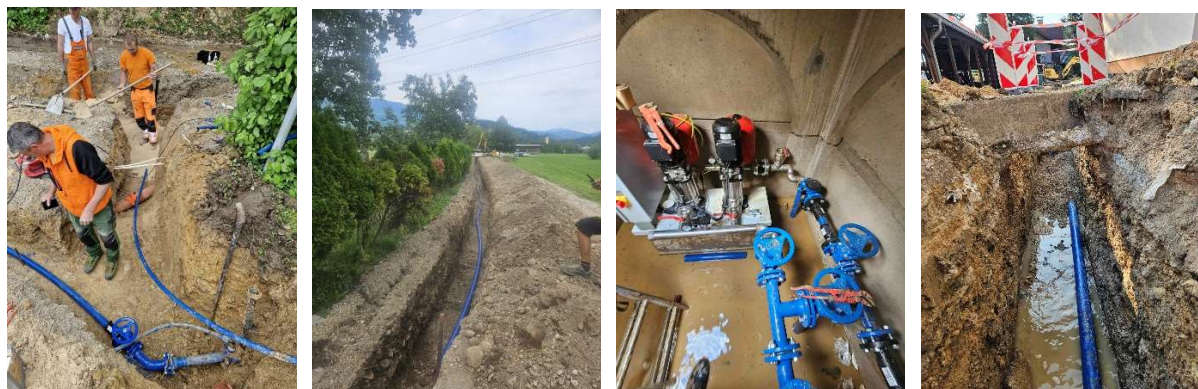
Slike: 1. Gradnja vodovoda Rožnik v sklopu rekonstrukcije ceste na Rožnik 2. Izgradnja povezovalnega krožnega voda v Lokah pri Mozirju Hišovec - Vrhovnik 3. Montaža hidropostaje črpališče Krahelnovo 4. Obnova AC vodovoda za Pepelom
