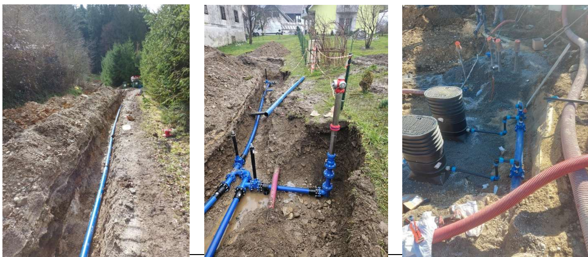
Slike: 1. Prestavitev in obnova AC vodovoda na Lazah, 2. Obnova vodovoda v Zgornjih Krašah 3. Prestavitev vodovoda in izgradnja novih vodovodnih priključkov ZD Nazarje
