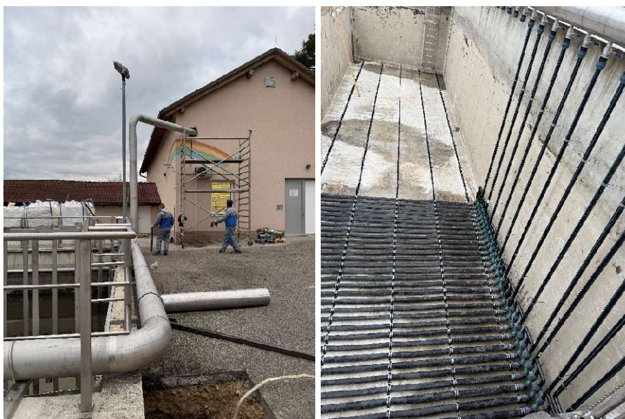
Slika 3, 4: zamenjava cevovodov in prezračevanja
