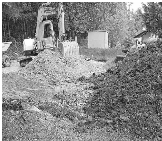
Obnova ceste Samostanska pot
