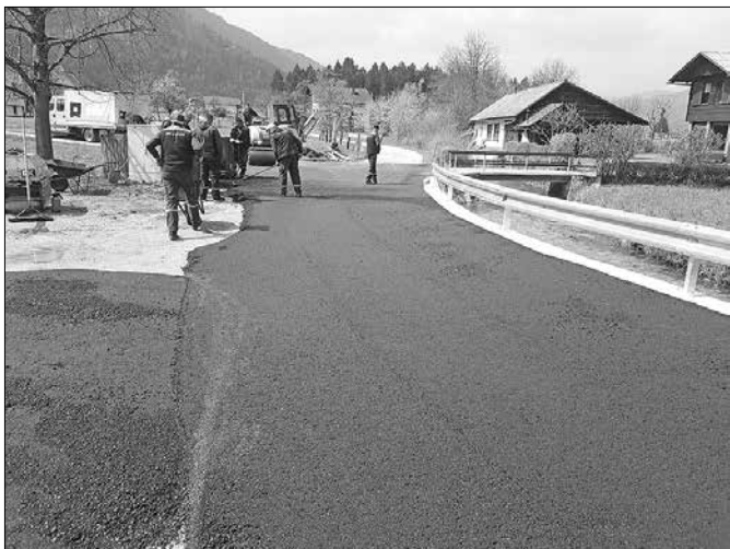
Obnova ceste Volog–Mali Rovt
