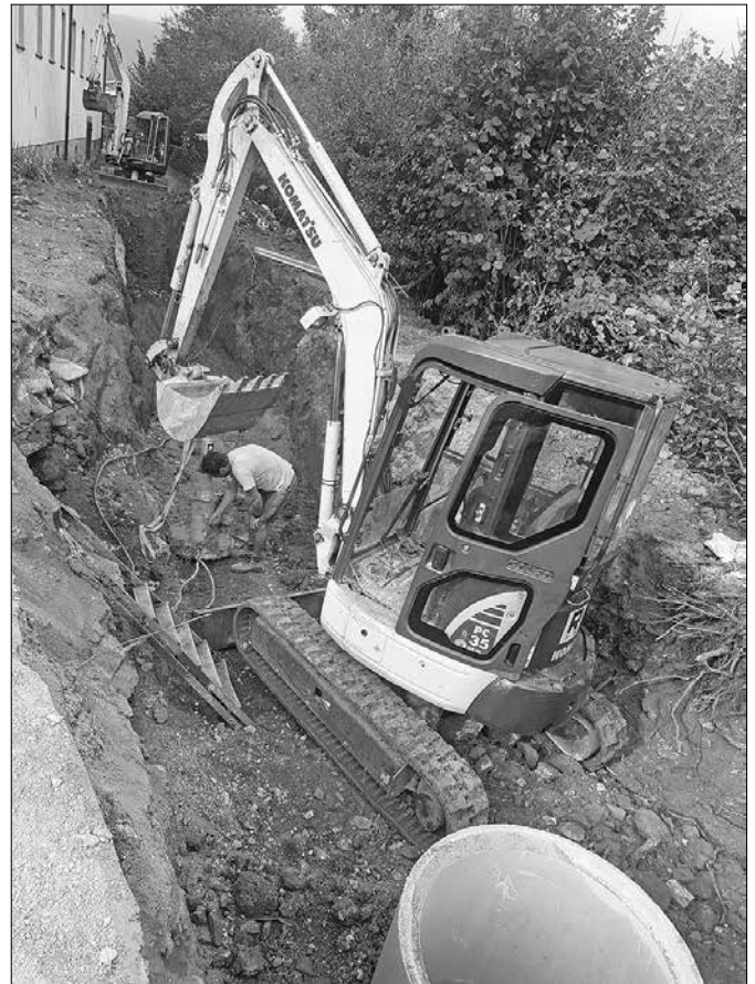
Gradnja kanalizacije na samostanskem hribu
