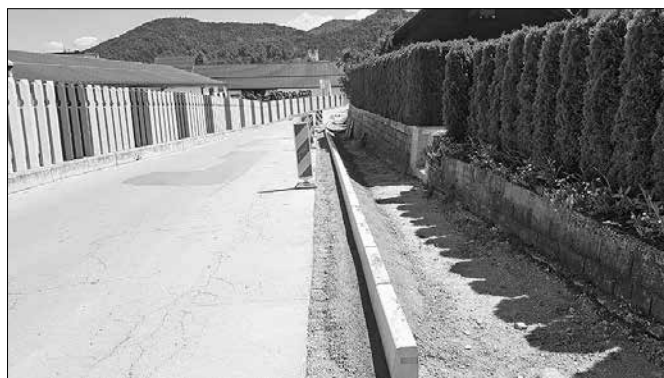
Pločnik Lesarska ulica 2. faza
