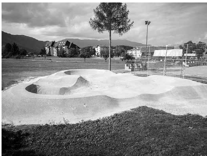
Izgradnja koloparka pri športnem igrišču se bliža koncu. (Foto: Nastasja Kotnik)
